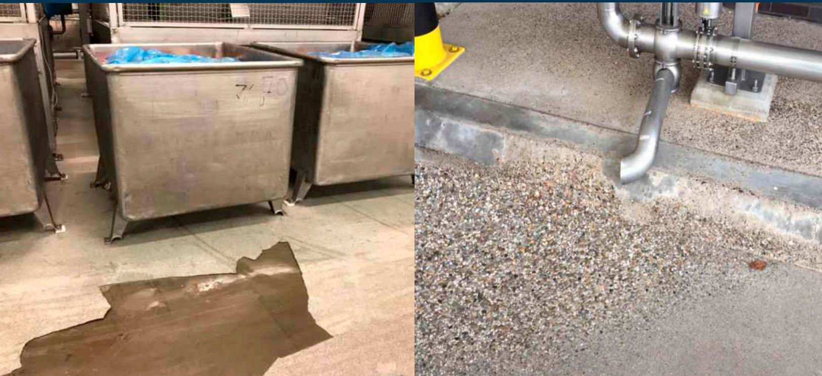
Se requiere una ingeniería de piso y una empresa con experiencia para realizar la selección adecuada, ya sea un piso de mortero llanado, un mortero autonivelante o un piso lanzado de hojuelas. Existen diversas opciones, y la elección depende de las necesidades específicas de cada industria y de las particularidades de cada área.
