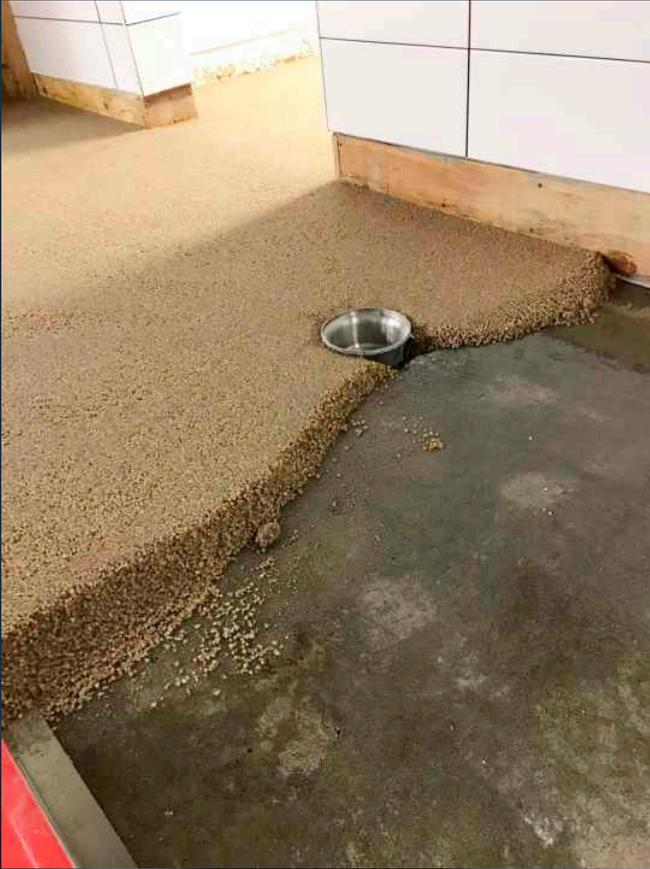
Antes de instalar un piso polimérico, se pueden utilizar grouts cementicios, epóxicos o autonivelantes, así como morteros, para realizar rellenos y preparar adecuadamente cada área.
