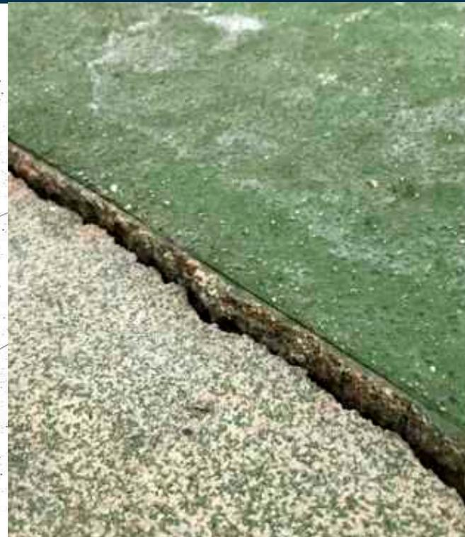
No todas las juntas se tratan igual. Una junta de control se maneja de manera diferente a una junta de expansión o una junta de aislamiento de una columna. Por ejemplo, el tratamiento de junta oculta es utilizado en juntas de control.
