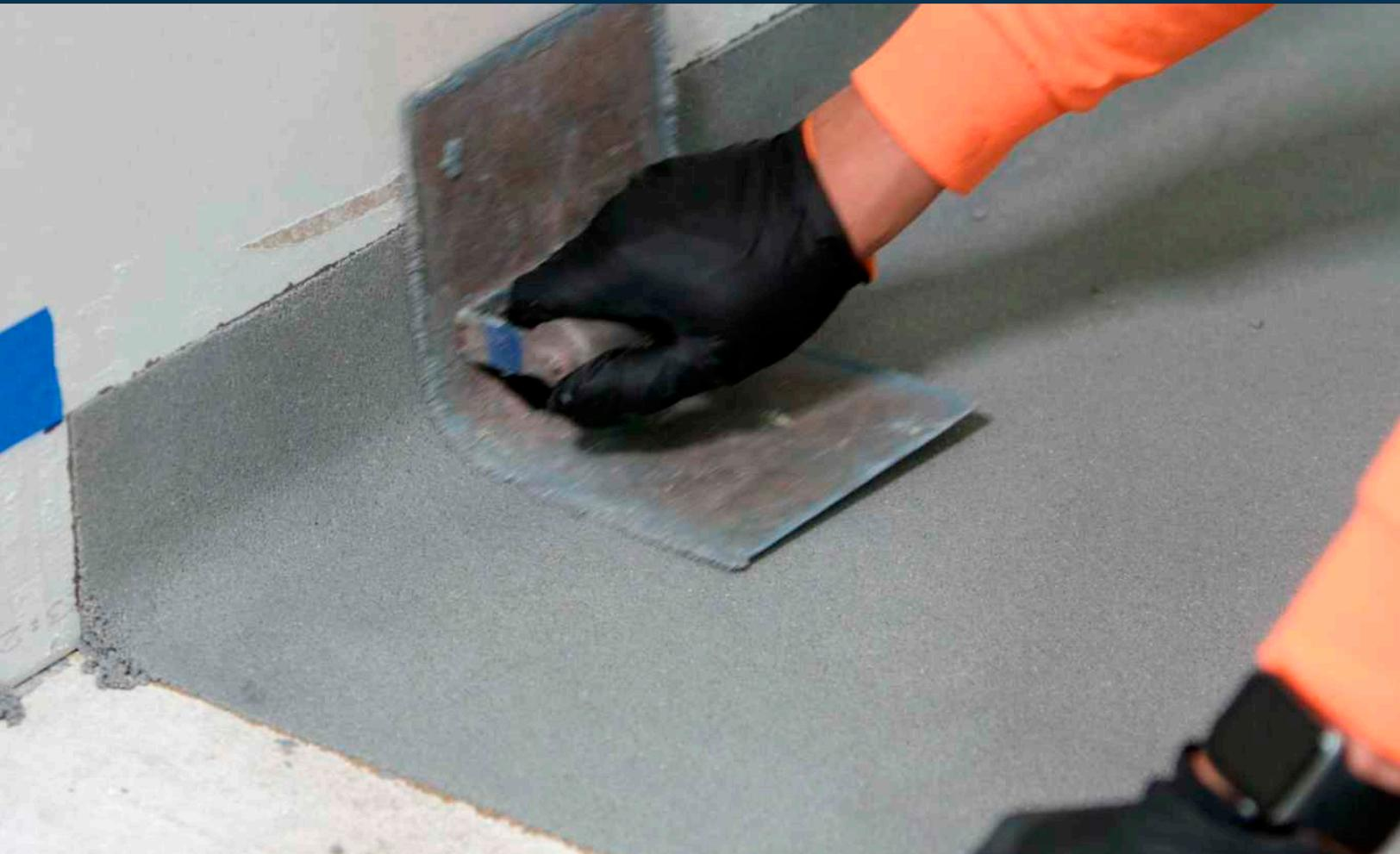
Esto se logra seleccionando sistemas de piso en los que la curva sea integrada y fabricada con el mismo material del piso, en lugar de utilizar materiales prefabricados o distintos que generen juntas y fisuras propensas al crecimiento de hongos y bacterias.
